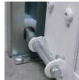
Support anti-effraction fixés au sol
